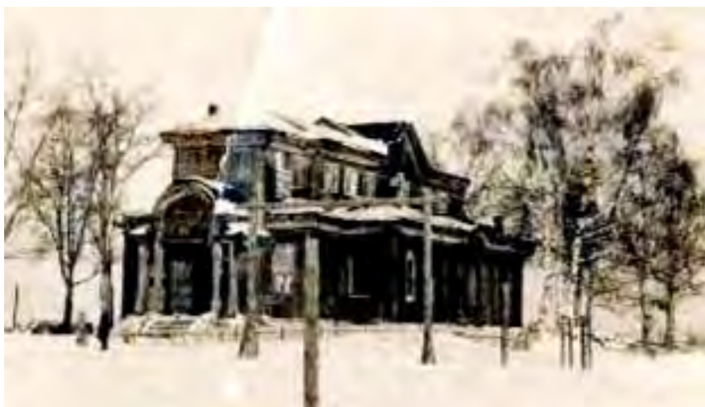
Здание бывшей церкви св. Александра Невского
